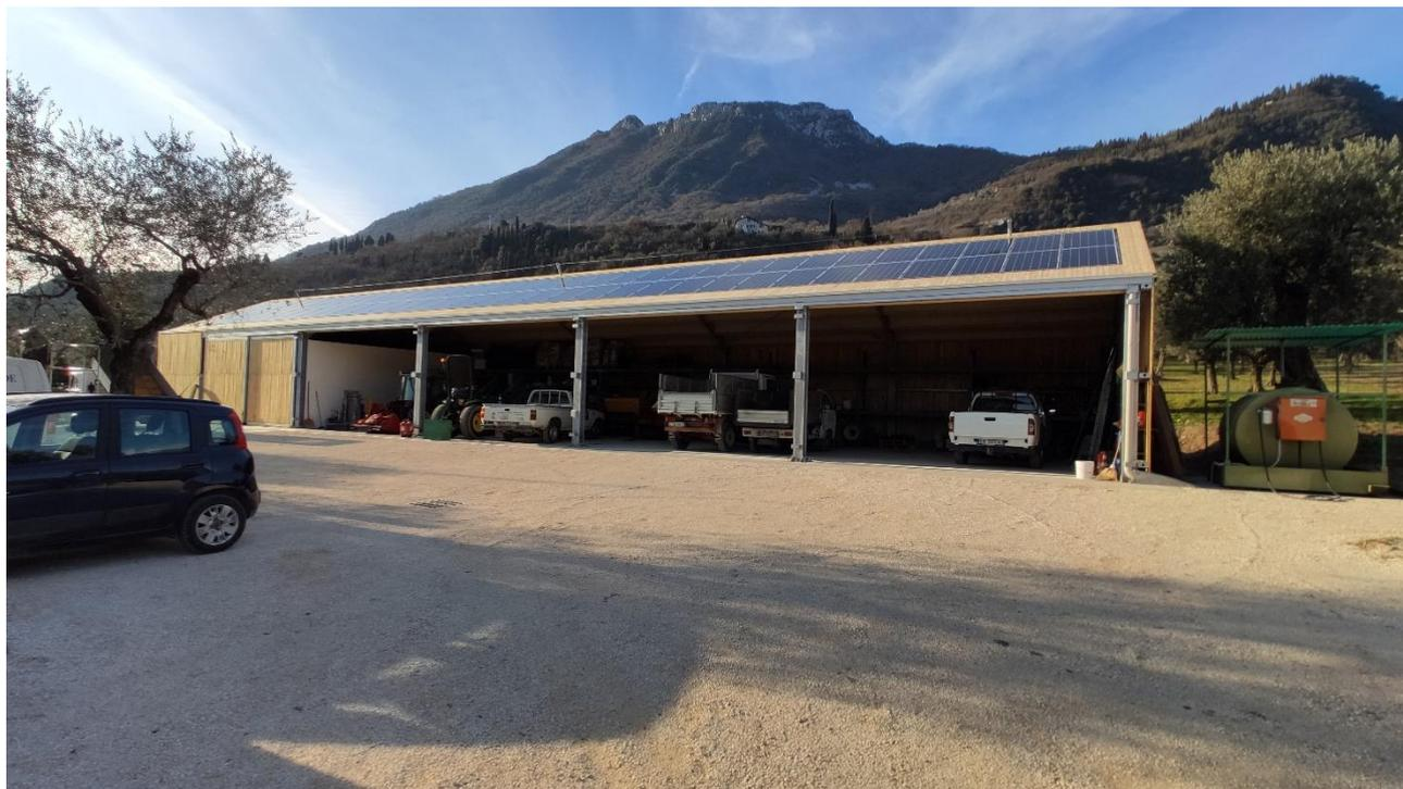
1- Struttura metallica con rivestimento in legno e FTV in falda.
