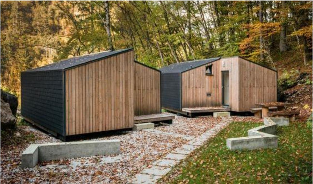
7- Rivestimento in legno, manto di copertura e parte del rivestimento in scandole in metallo.
