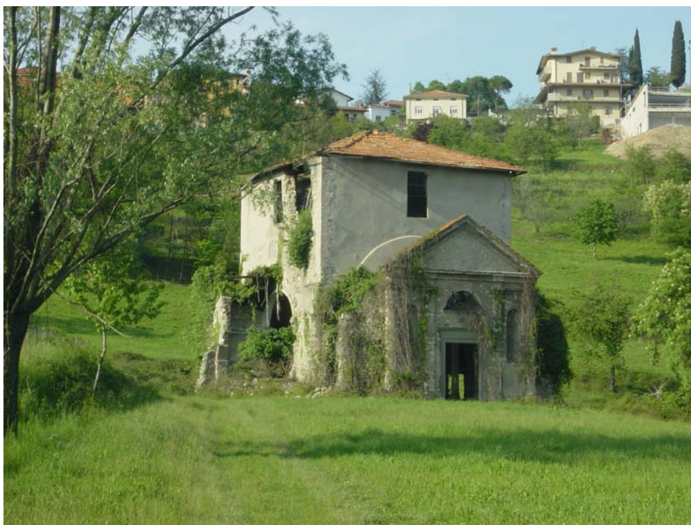
Foto 13 - Chiesa abbandonata di San Giovanni nei Boschi
