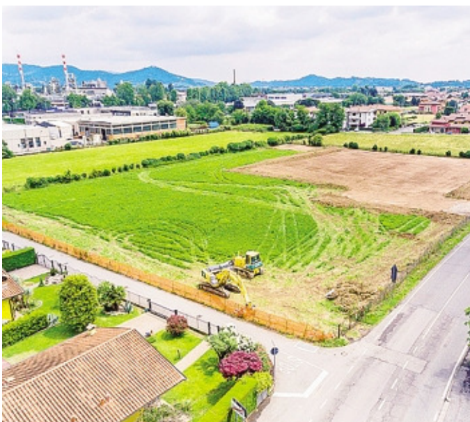
L'area al confine con Pedrengo dove sorgerà l'edificio FOTO ALEX PERSICO
