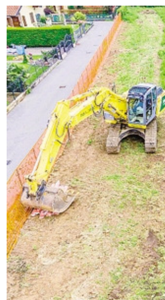
Partiti i primi lavori
