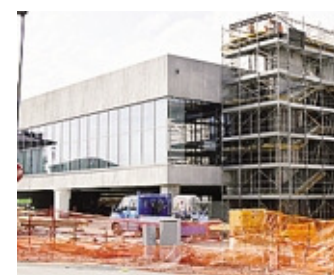
Il supermercato in costruzione
