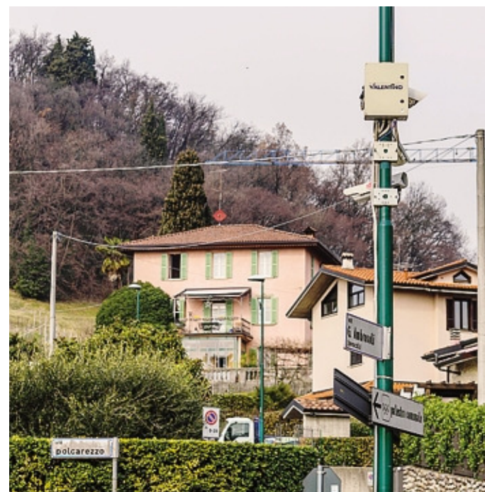
L'impianto allestito in via Polcarezzo
