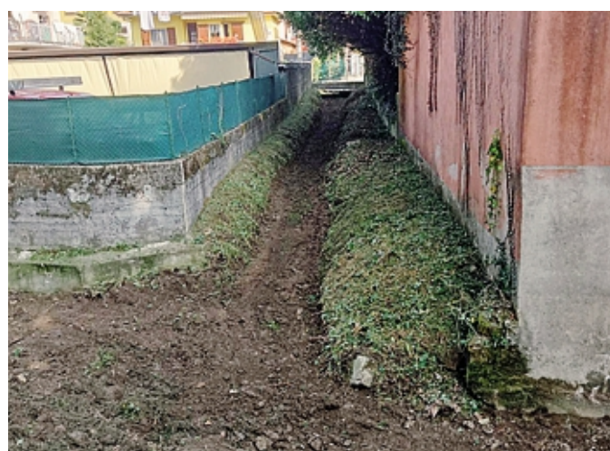
L'intervento di sistemazione dell'alveo del torrente Gavarnia
