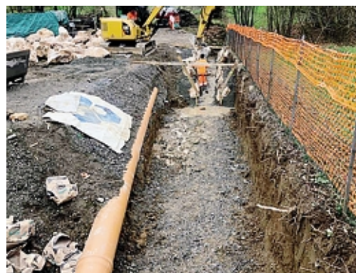
I lavori eseguiti al torrente Gavarnia
