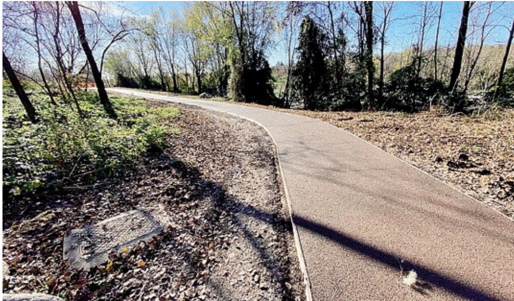
Un tratto di pista ciclopedonale riquilificata alle Ghiaie di Paladina per lo più con i contributi del Gal
