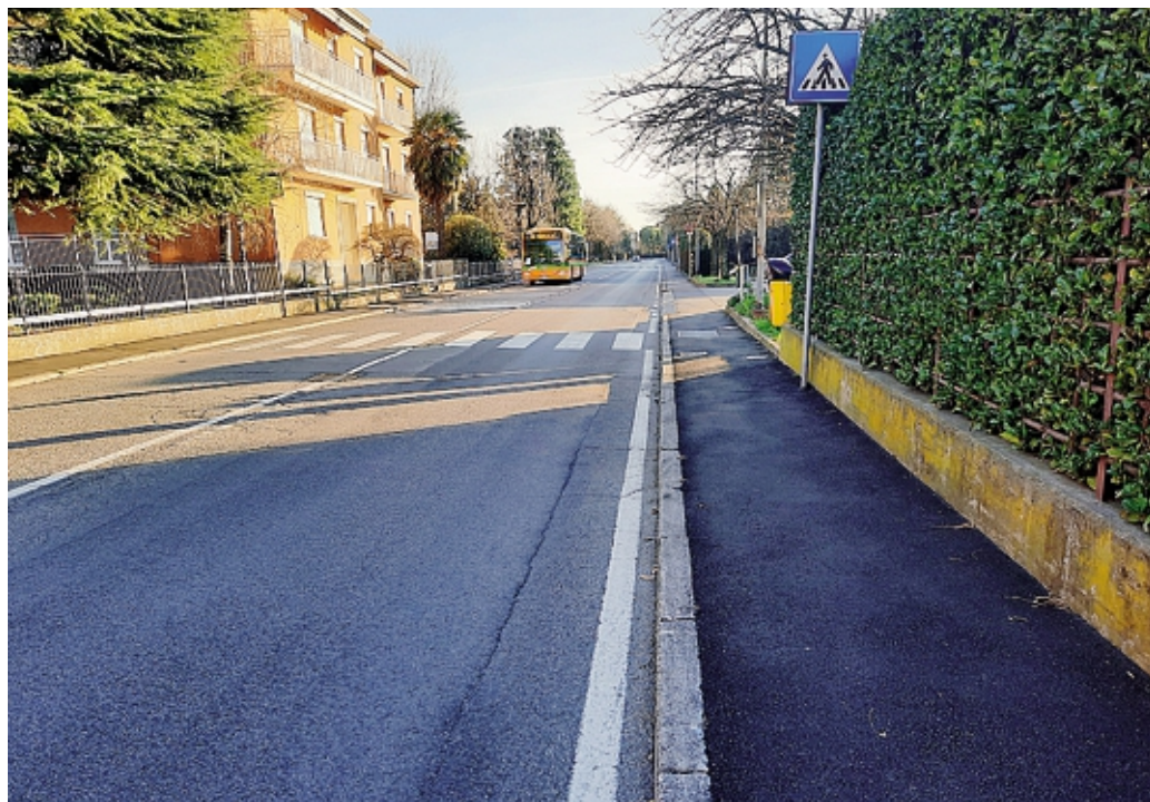
Immagine di marciapiedi recentemente asfaltati in via Emilia alla Marigolda di Curno
