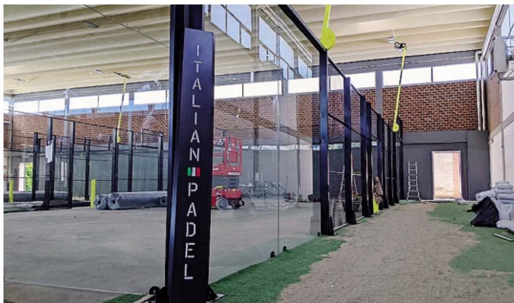
I lavori all'interno della struttura alla Tennis Academy Manenti Malgaroli a Brusaporto
