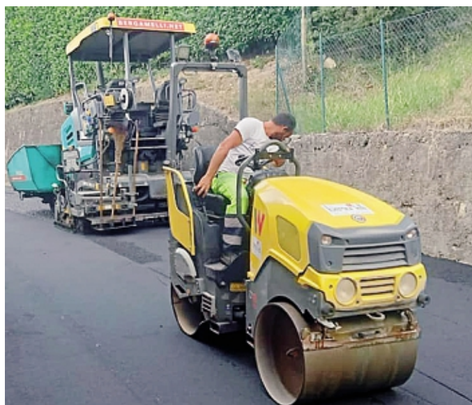
Lavori di asfaltatura in via Collina Alta
