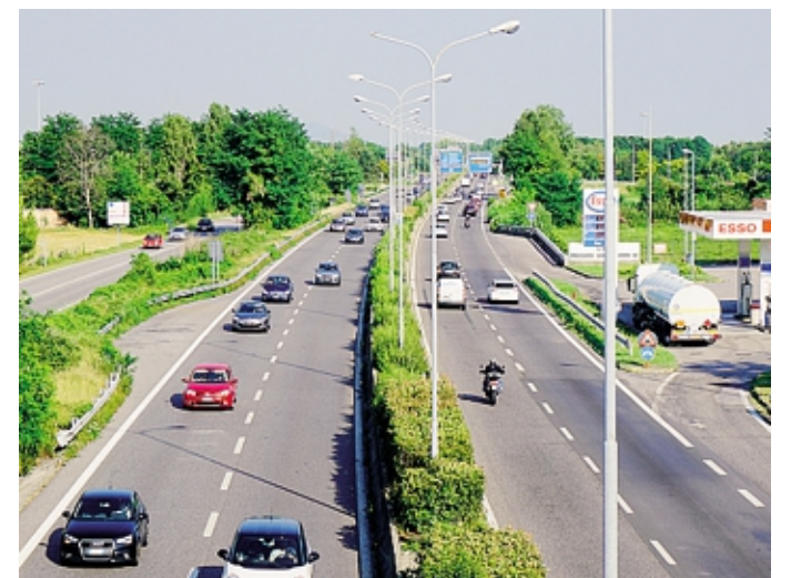
L'Asse interurbano: si interverrà all'altezza del ponte sul Serio
