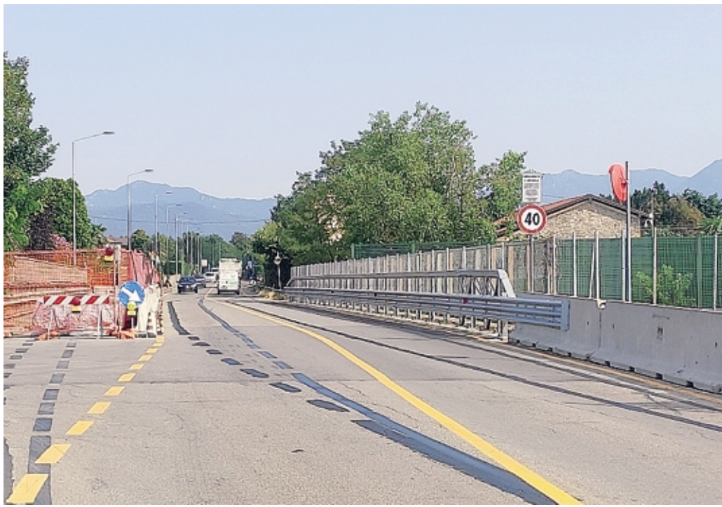
Il cantiere sul cavalcavia dell'autostrada A4 all'altezza di Cassinone
