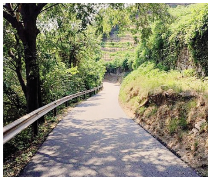
Scanzo: via Monte Bastia, la strada della collina, risistemata
