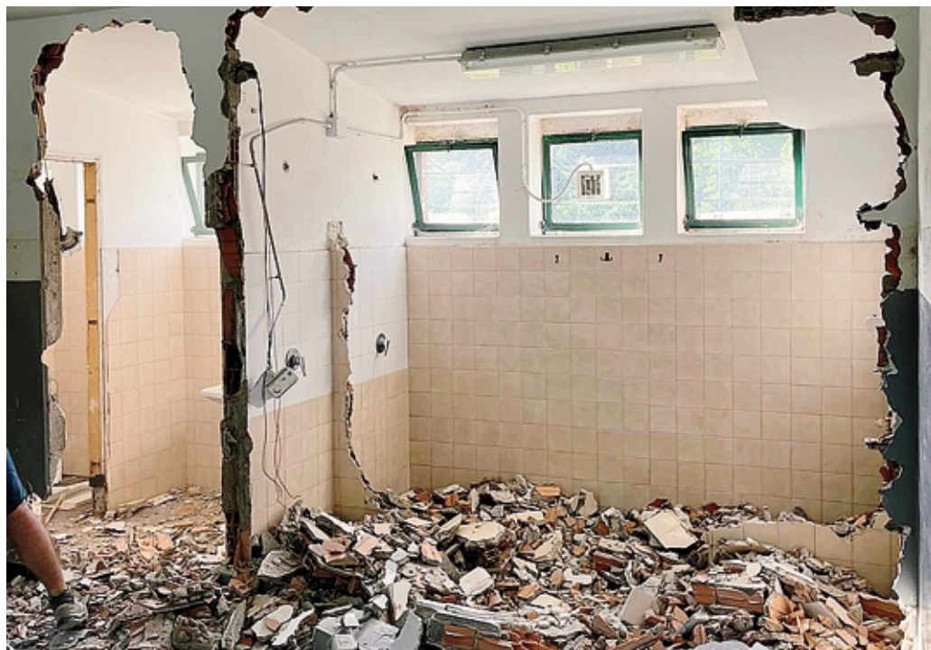
Lavori in corso negli spogliatoi del centro sportivo di Tribulina a Scanzorosciate
