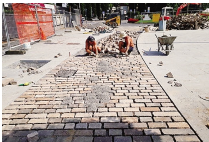
Ultimi lavori per la posa della pavimentazione in via Colleoni
