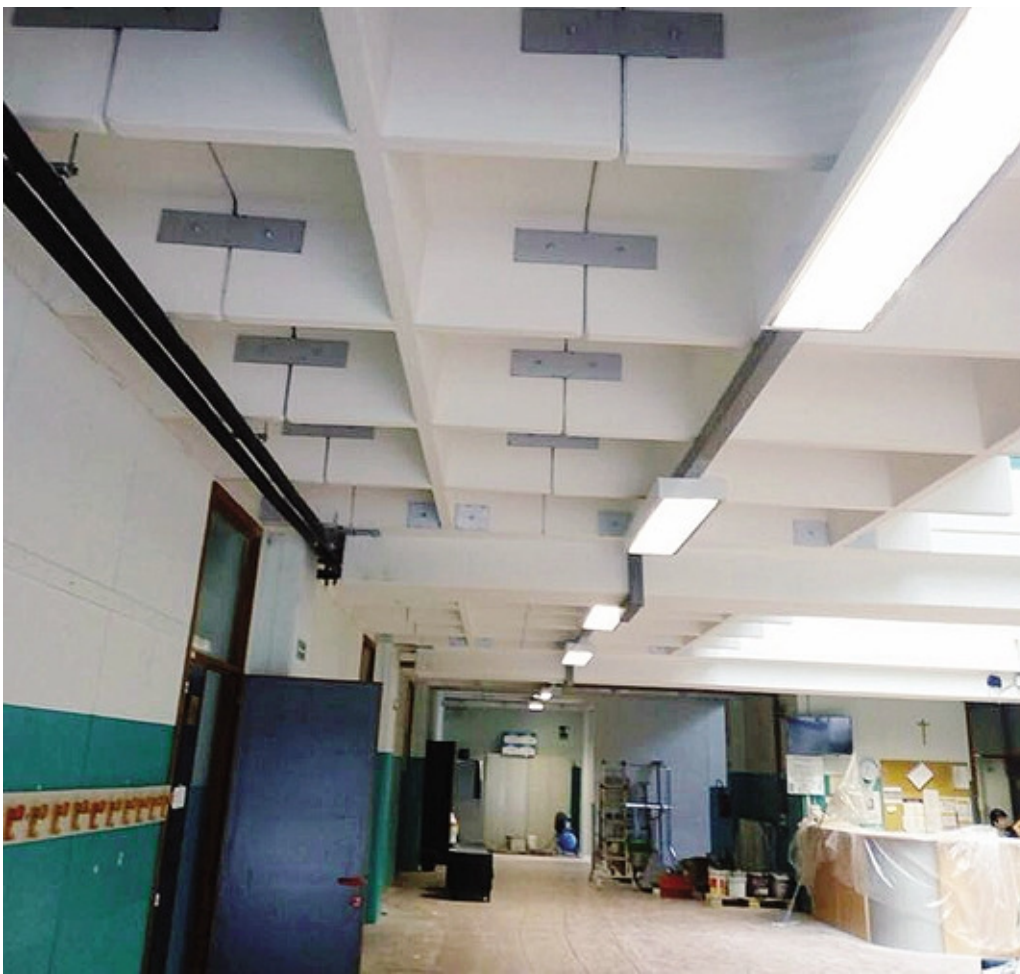
I lavori in corso alla scuola media di via degli Orti a Scanzorosciate
