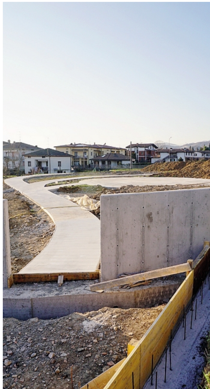
I lavori per l'allestimento del parco a isole FOTO COLLEONI
