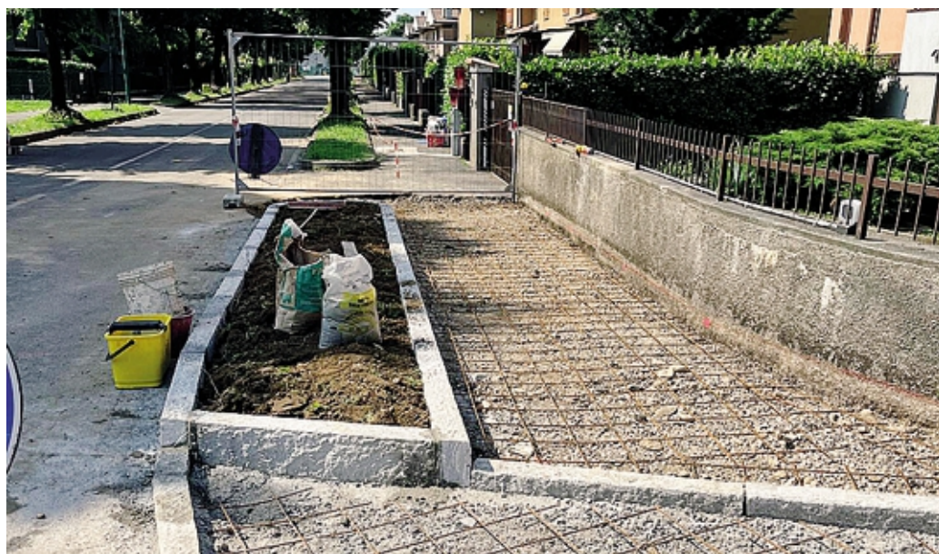
I lavori in via Fratelli Cervi a Scanzorosciate
