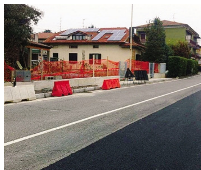
Alcuni lavori di asfaltatura a Pedrengo
