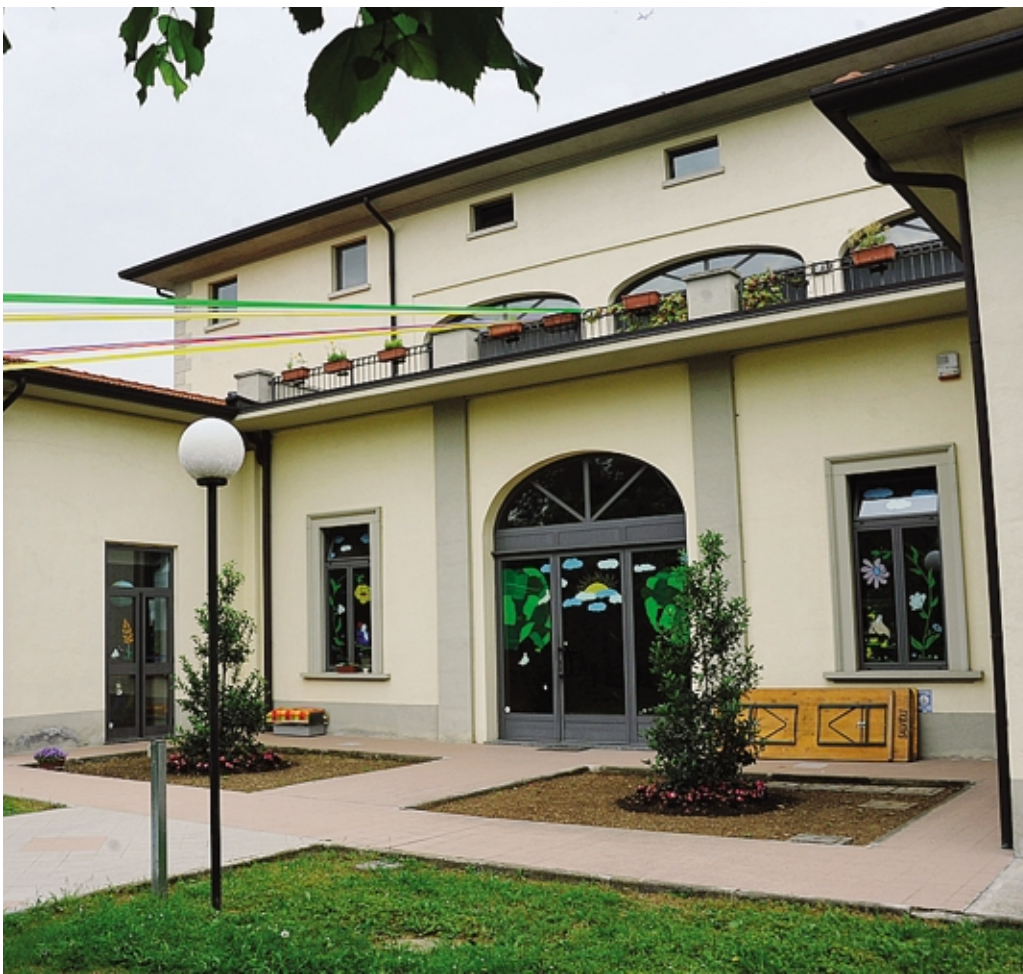
La scuola dell'infanzia di Stezzano
