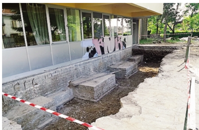
Uno scavo per l'intervento di adeguamento sismico
