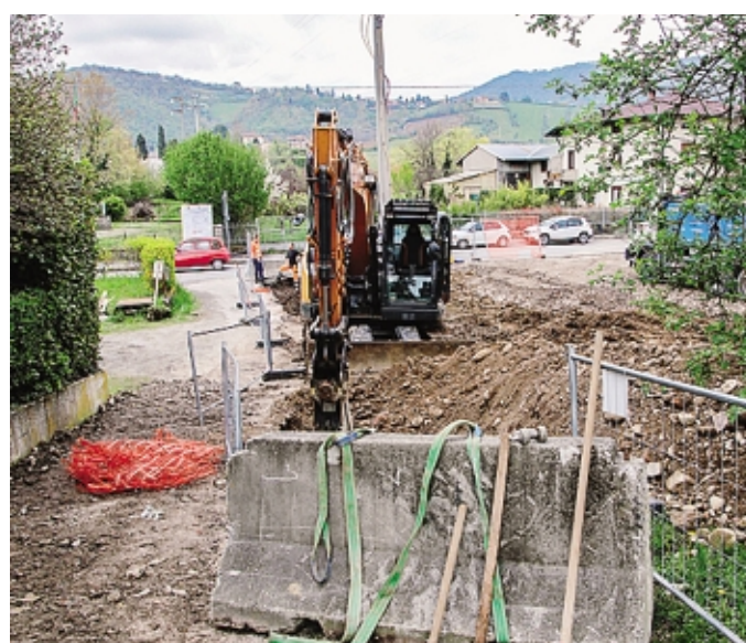
I lavori sul torrente Gamberone sono stati individuati come prioritari
