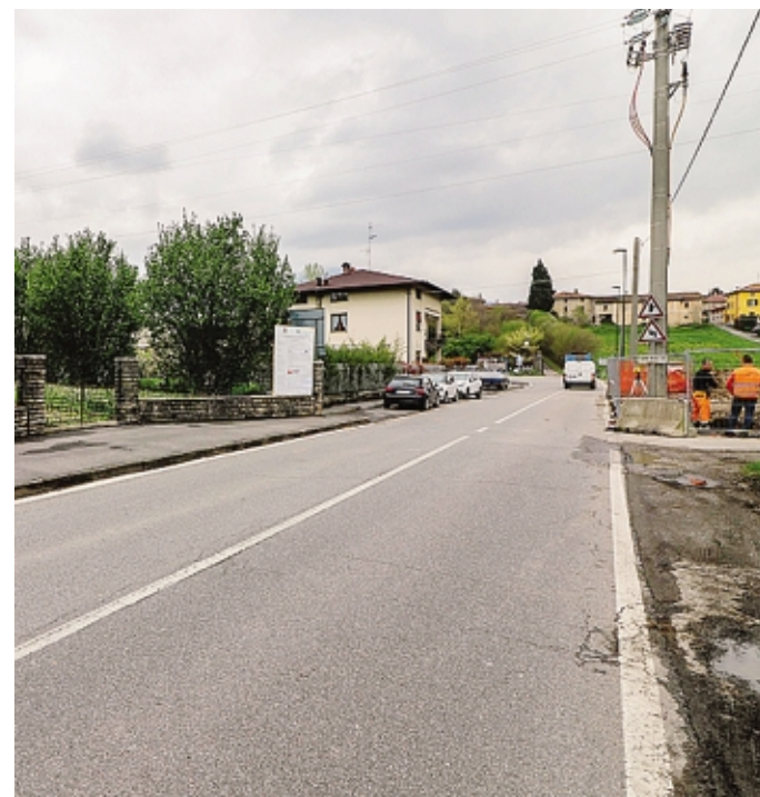
I lavori interessano anche un tratto della Sp 68
