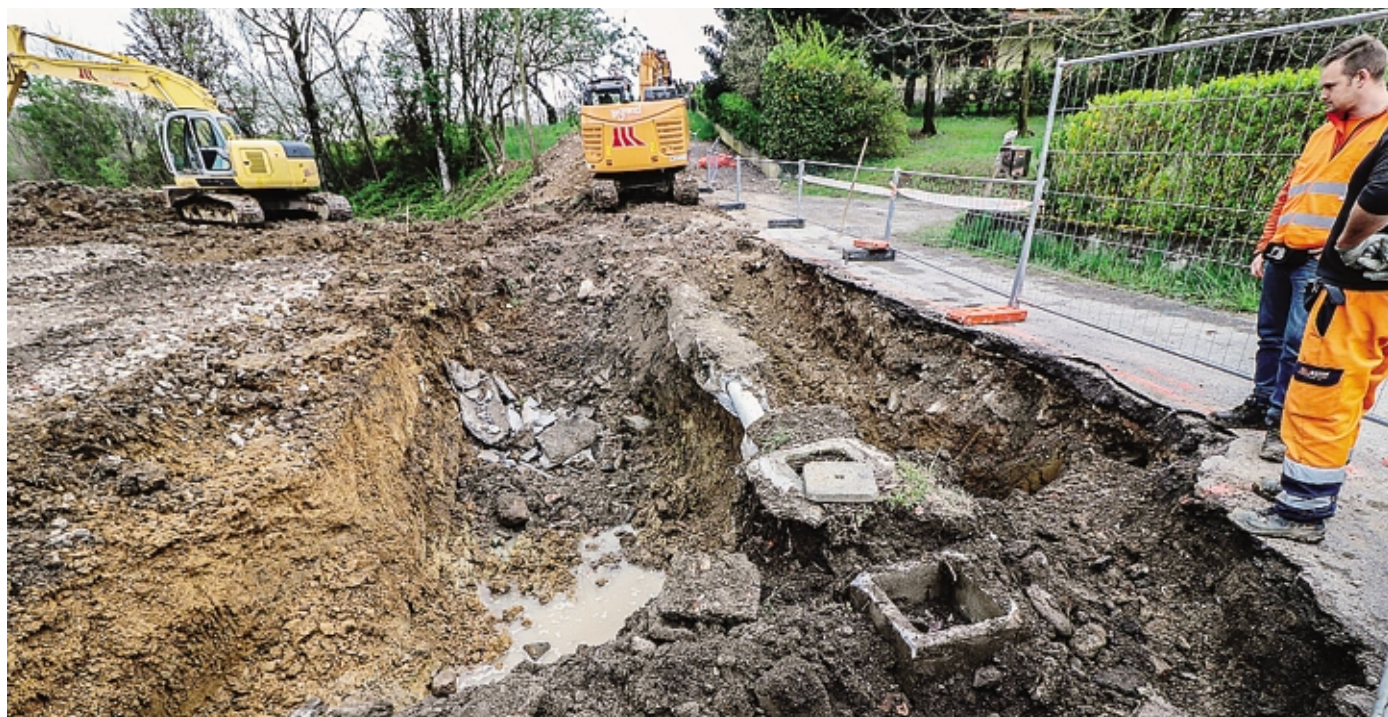
L'intervento in corso sul torrente Gamberone a Negrone FOTO GIAVAZZI
