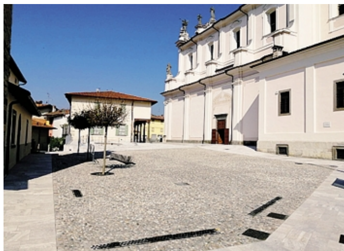
Parte del sagrato della chiesa già rimesso a nuovo
