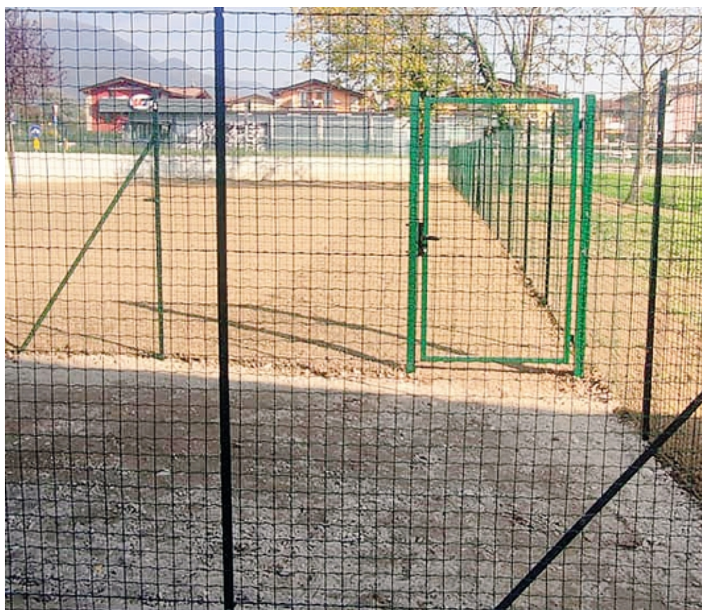
La nuova area cani in corso di realizzazione da parte del Comune nella frazione di Negrone
