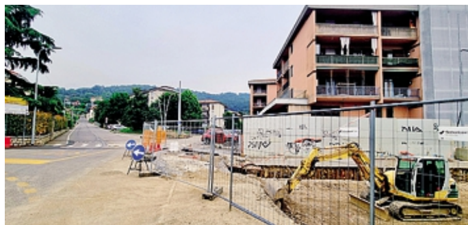
Il cantiere Teb all'altezza di via Maresana BEDOLIS
