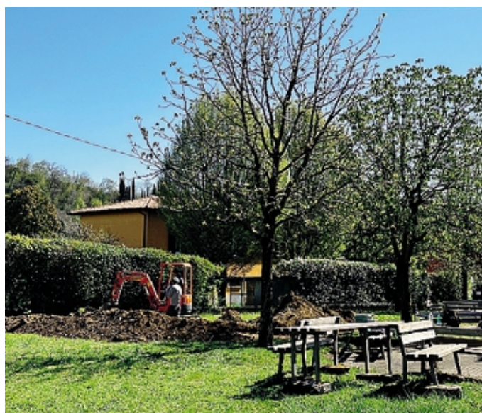
Scavatore al lavoro nel parco Santa Lucia di via Todeschini a Mozzo
