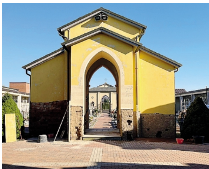
Lavori al cimitero di Brusaporto, che è in fase di restauro
