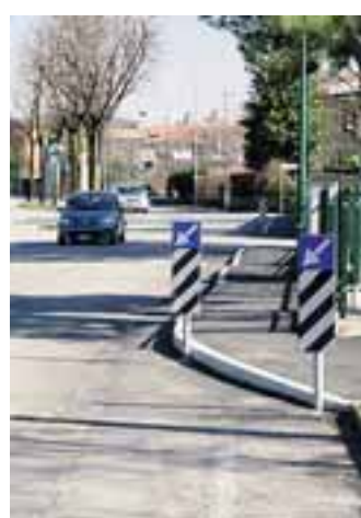
Il nuovo marciapiede di Scanzo
