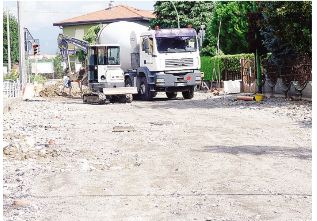
Lavori in corso in via Europa a Grassobbio
