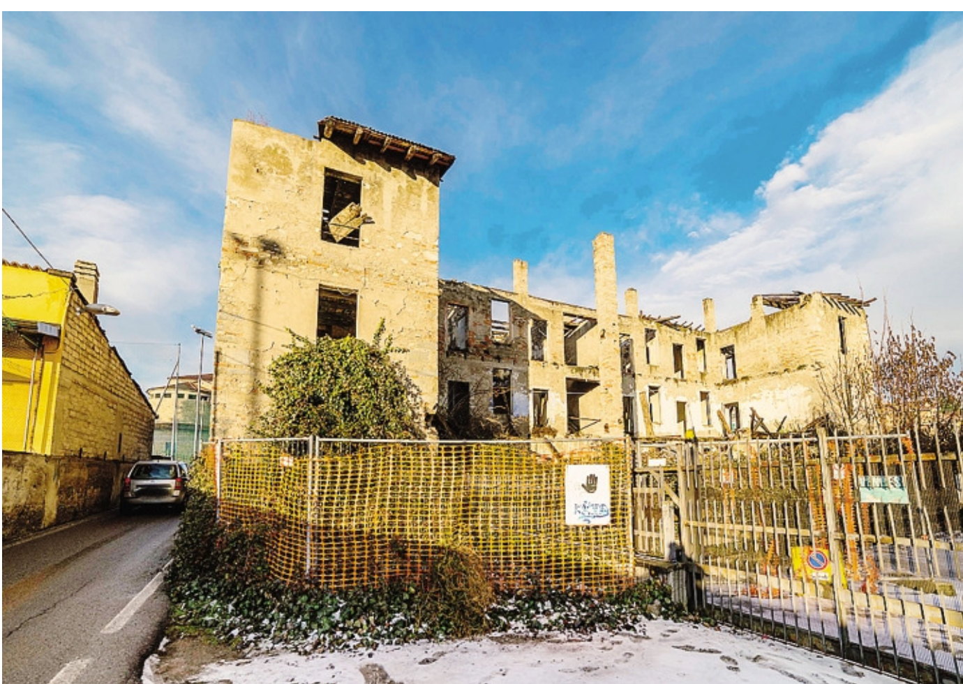
Partiranno lunedì i lavori per la demolizione della Cascina Santa a Scanzorosciate FOTO ALEX PERSICO
