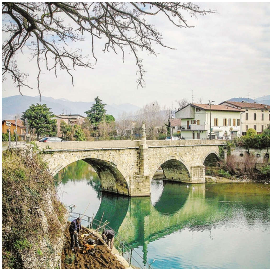
Il ponte di Gorle nei pressi del quale verrà realizzato il nuovo collegamento ciclopedonale
