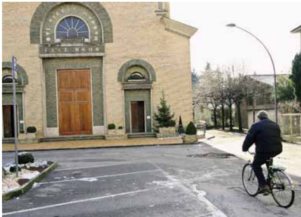
In piazza Monsignor Radici, a Scanzo, sarà rifatta la pavimentazione FOTO ZANCHI
