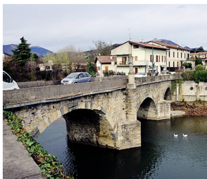
Il traffico sul ponte di Gorle supera anche i 1.300 mezzi all'ora
