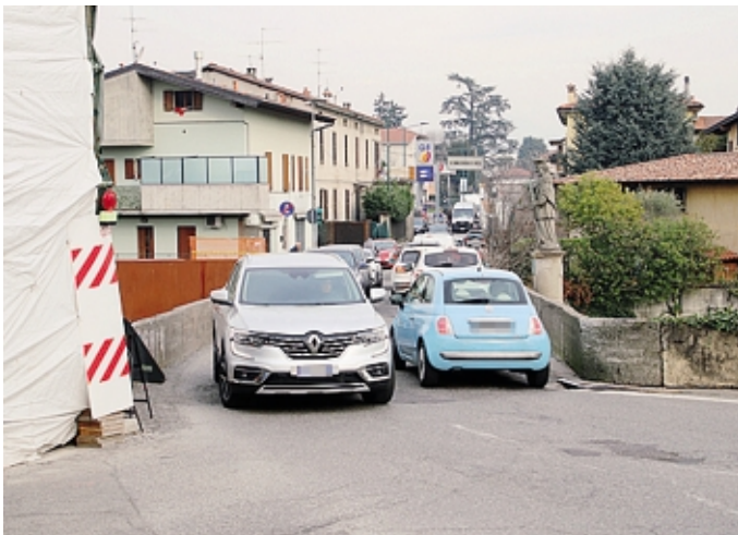
Il ponte romano tra Gorle e Scanzorosciate FOTO COLLEONI
