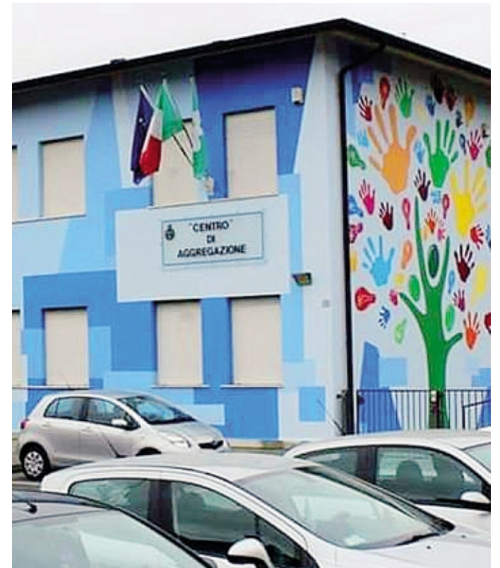
Pedrengo, Sportello Lavoro al Centro di aggregazione
